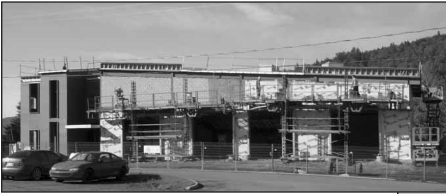
Caserne des pompiers
