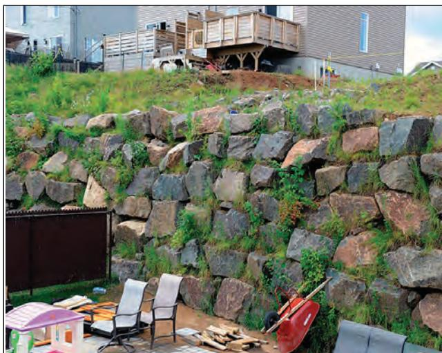
Photo: V. Coulombe Le remblai derrière le mur s'est écoulé...
