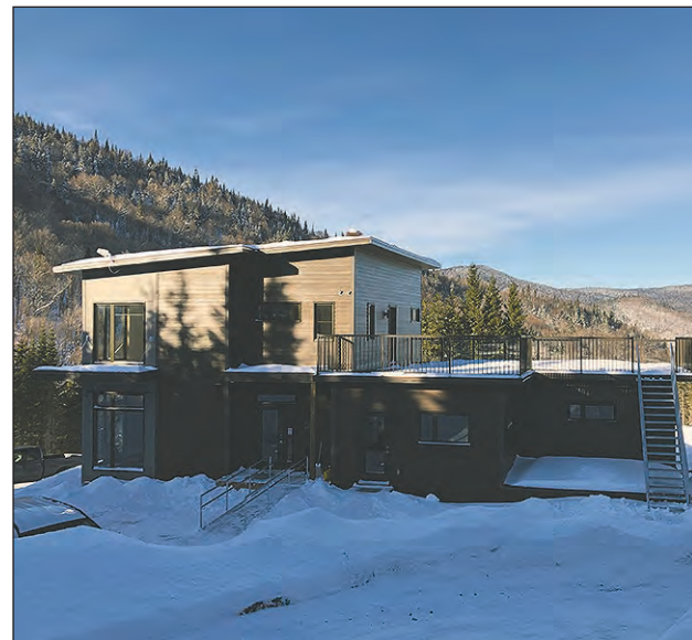
Bâtiment destiné à l'accueil et à la location
