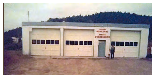
Premier garage municipal
